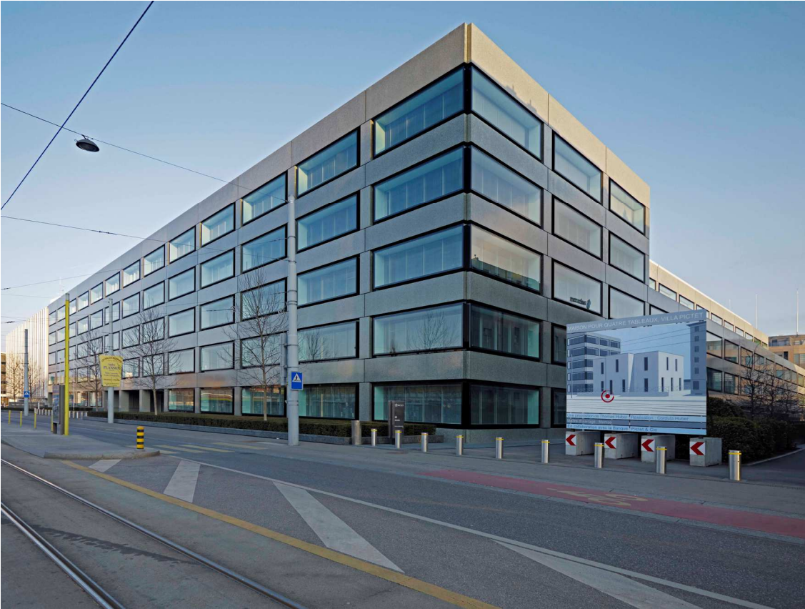
« Maison pour quatre tableaux, villa Pictet », 2012, panneau de chantier : acrylique sur plaque en forex, en plusieurs parties, Mamco, Genève, TH-2012-BS-05
