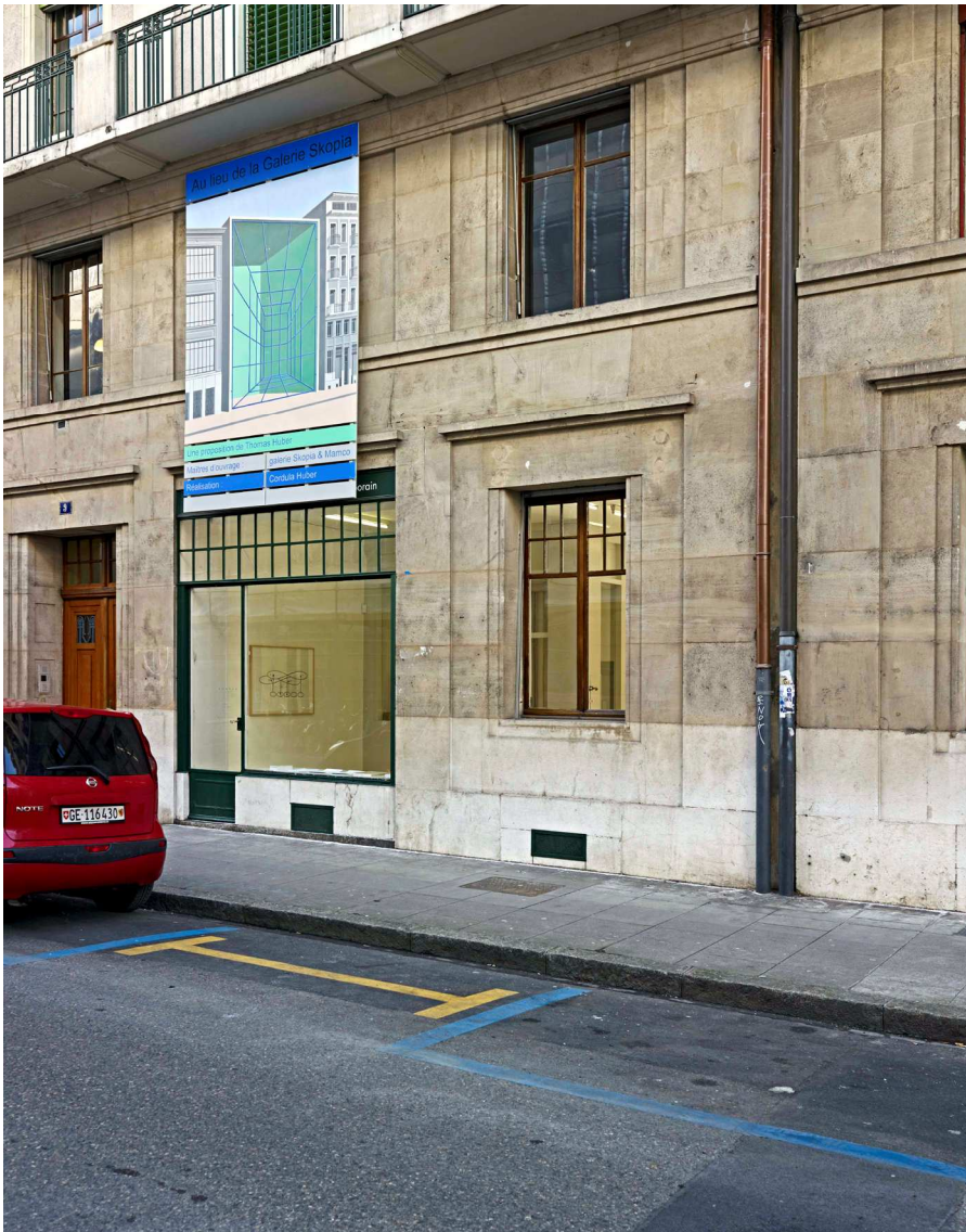
« Au Lieu de la Galerie Skopia », 2012, panneau de chantier : acrylique sur plaque en forex, en plusieurs parties, Mamco, Genève, TH-2012-BS-01
